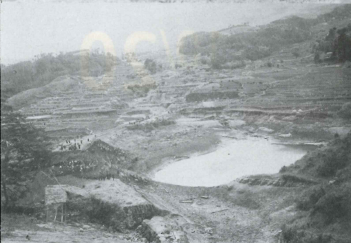
提供/西岡家 溜池修理工事(明治37年)
